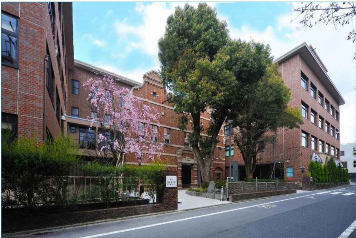
2019年3月に耐震補強工事を完了し、外壁も一新した大学京都キャンパス
